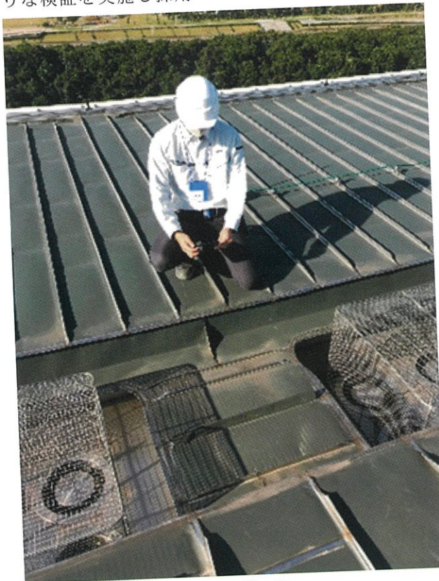
屋根雨水排水部
