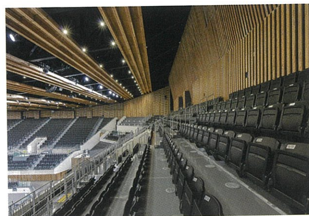
木ルーバーと吸音材による内壁 ※
