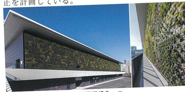
大型壁面緑化 ※
