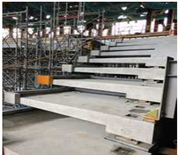
대형 홀 사이드 발코니 바닥의 PC판 (최하단 PC판 밀동 위아래에 방진고무가 보인다)
