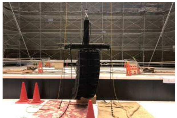
사진4 대형 홀 무대 전면 스피커 시공 상황
