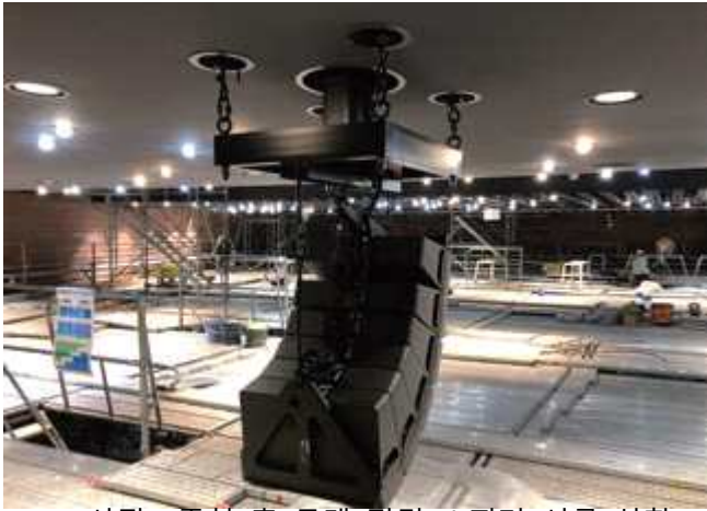
사진5 중형 홀 무대 전면 스피커 시공 상황
