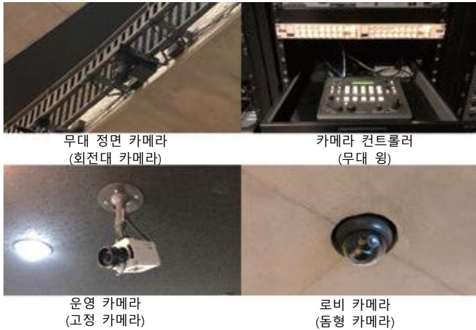
사진8 곳곳의 ITV 카메라 및 카메라 컨트롤러
