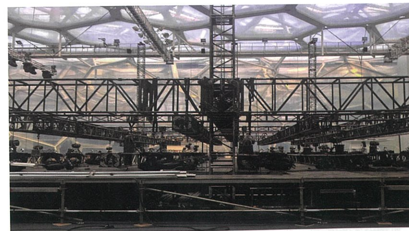
图2 舞台基架、桁架与棚顶下设吊点情况
