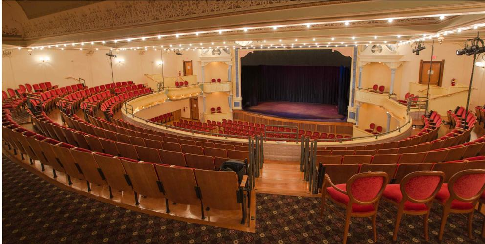
그림 C2-8 좌석 각 열 끝단, 객석통로의 불연속적인 안전난간의 예
