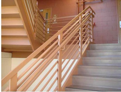
그림 C2-1 어린이용 하단난간이 설치된 예
