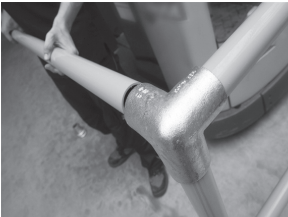
〈작업자 보호를 위한 고소 작업대 난간 설치와 무대 갤러리 바닥에 놓은 작업 도구〉
