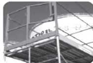
상부출입구 및 품목 설치
