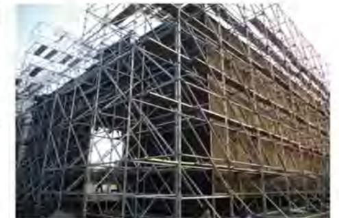
그림 6 부분 조립식 구조물의 설치 현장
