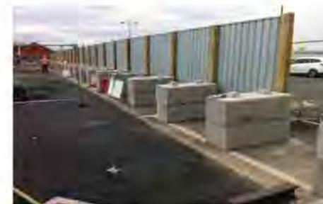
그림 20 켄틀리지 설치 상태 예
