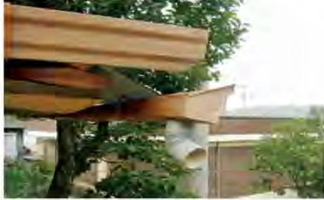
그림 28 우수관 설치 예
