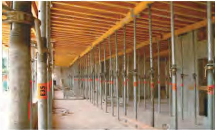
그림 48 버팀목 설치 예
