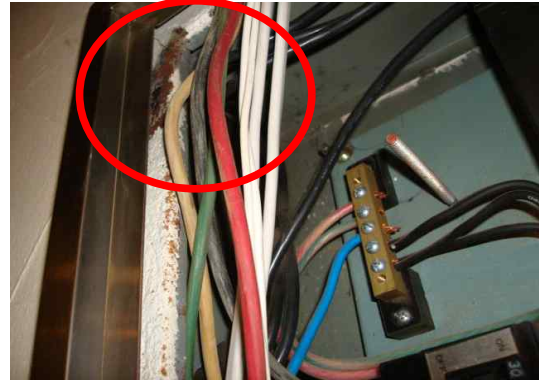
그림 163 배선상태 미흡으로 누전 차단기 스위치와 간섭 (불량) 그림 164 배선상태 미흡으로 배전함 덮개와 간섭 (불량)
