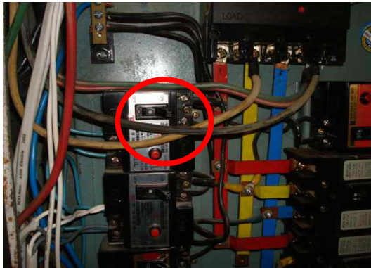
그림 163 배선상태 미흡으로 누전 차단기 스위치와 간섭 (불량) 그림 164 배선상태 미흡으로 배전함 덮개와 간섭 (불량)
