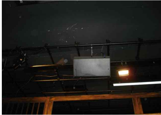
그림 201 스피커 고정 방법 미흡 - 와이어로프 사용 (불량)
