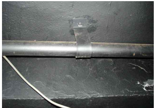
그림 189 천장에 앵커링 없이 볼트로만 장치봉 고정 (불량)
