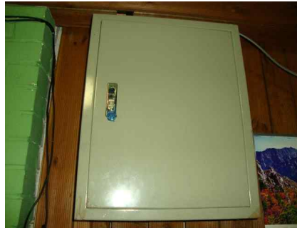
그림 68 배전반 외함 강재 구성 및 부식, 변형 미발생 예
