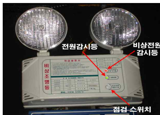
그림 41 비상조명등 점검 스위치 및 전원 감시등
