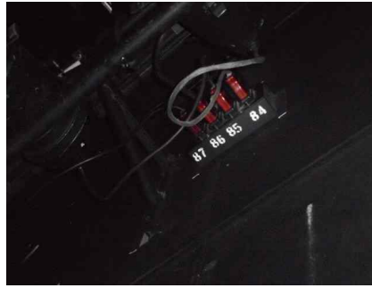
그림 90 접속함 내 C형 접속기 접속상태 예
