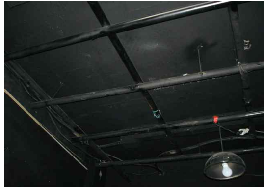
그림 195 장치봉과 건축구조물 앵커를 점용접으로 고정 (불량)
