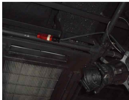
그림 91 C형 접속기 연장코드와 접속상태 예
