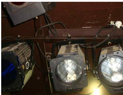
그림 113 조명기 내 안전망 설치 예
