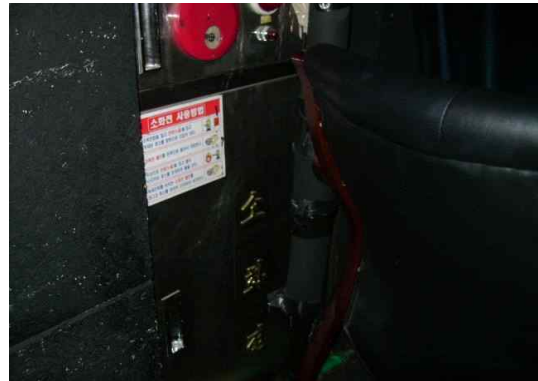
그림 143 소화전 설치상태 불량 (소화전 내 적재물 있음)
