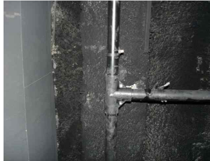
그림 101 그리드 구성부재의 끝단부 마감상태 예
