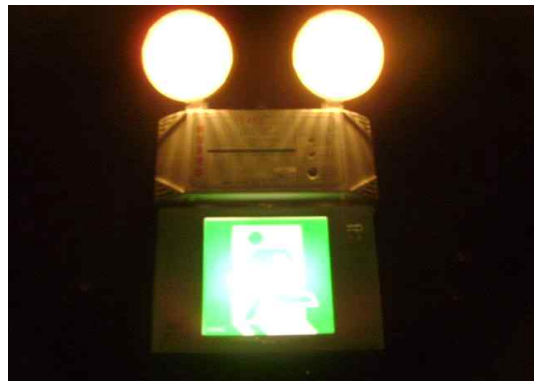
그림 40 비상조명등 작동 및 밝기 확인 (양호)
