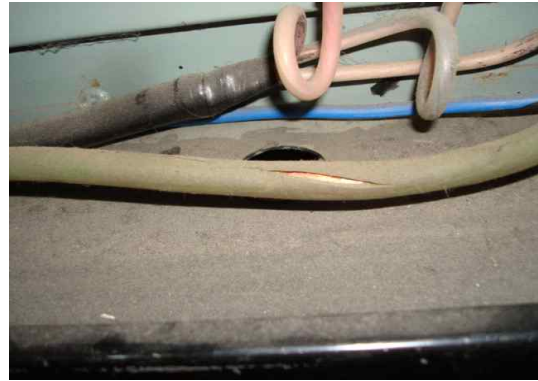
그림 179 배선의 피복상태 불량으로 내선이 들어남 (불량)
