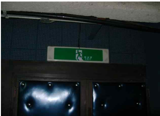
그림 132 피난구유도등 미점등 상태 (불량)
