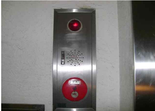
그림 138 비상벨 및 경보기 (예)
