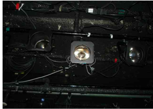
그림 198 조명기 안전망 미설치 (불량)
