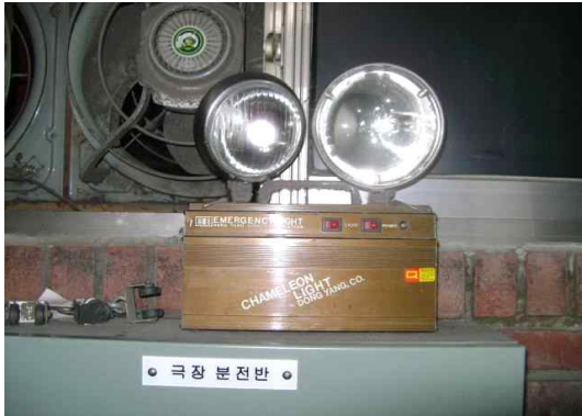
그림 134 비상등 설치상태 불량 (비상조명등 미고정)
