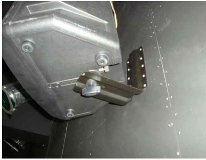
그림 111 벽면에 스피커 전용 브라켓 사용한 고정 예
