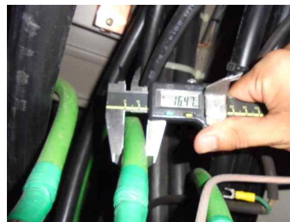
그림 81 배전반 내 전지선 굵기 측정 예
