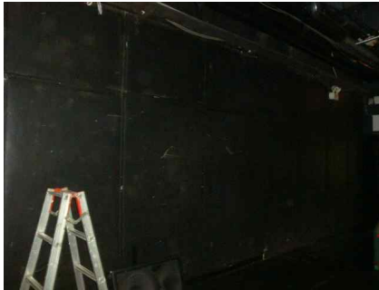
그림 119 무대 측면 누수, 균열 미발생 예
