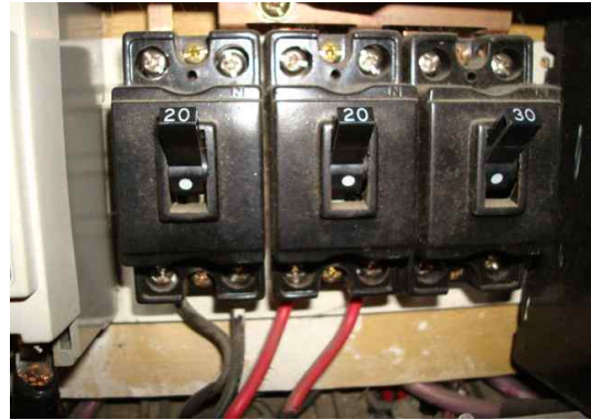
그림 160 누전 차단기의 테스트버튼 없음 (불량)
