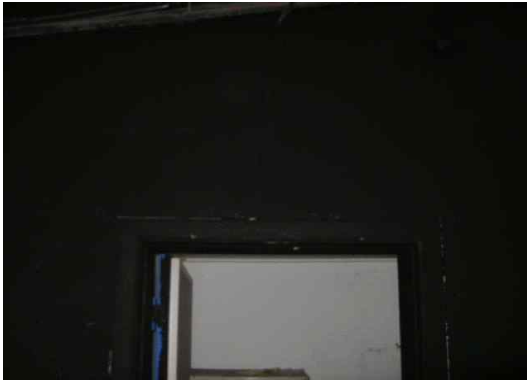
그림 130 피난구유도등 미설치 (불량)
