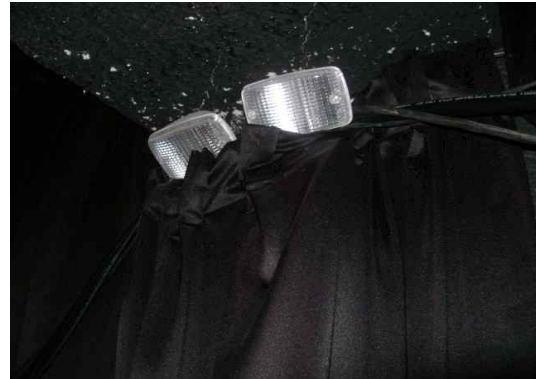
그림 135 비상등 점검상태 불량 (커튼 뒤에 설치되어 있어 점검의 원활성 및 비상등이 비추는 방향에 저해 요인이 됨)
