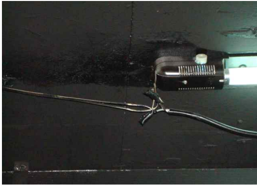
그림 178 배선 고정상태 미흡으로 배선 간 접속부에 장력 발생 (불량)
