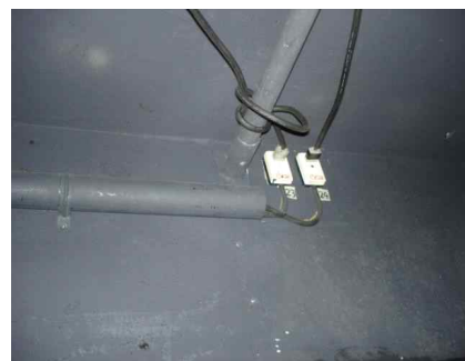
그림 106 벽면에 그리드 구성 부재 고정 예
