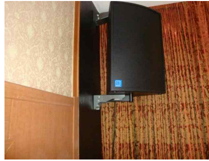
그림 112 벽면에 스피커 전용 브라켓 사용한 고정 예
