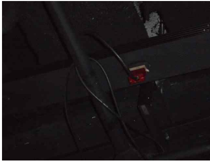
그림 89 금속덕트 내 C형 접속기 접속상태 예
