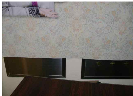
그림 144 소화전과 소방기구 주변상태 불량 (육안으로 소화전 및 소방기구 확인이 어려움)
