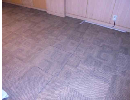
그림 86 가설용 전선 겹에 전선관 및 카페트 적용 예
