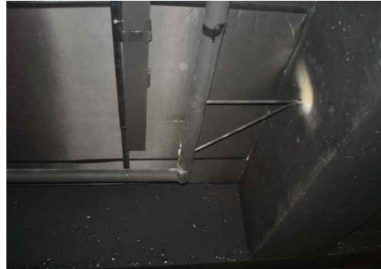
그림 187 건축구조물에 수평지지하였으나, 하중이 작용하기에 부적절 (불량)
