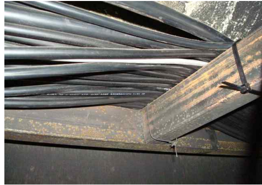
그림 175 덕트 및 전선관 또는 케이블트레이 등을 사용 요함 (불량)
