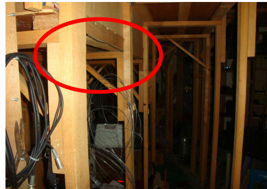
그림 54 미방염된 목재 구조물에 전기 배선이 적용됨 (불량)
