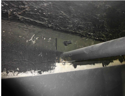
그림 100 그리드 구성부재의 끝단부 마감상태 예
