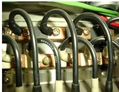
그림 62 전장부품 고정 전선 고정상태 예
