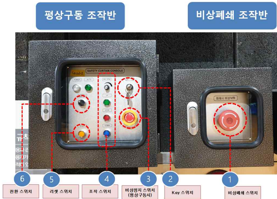
그림 4.2 구동 및 비상폐쇄 조작반 예
