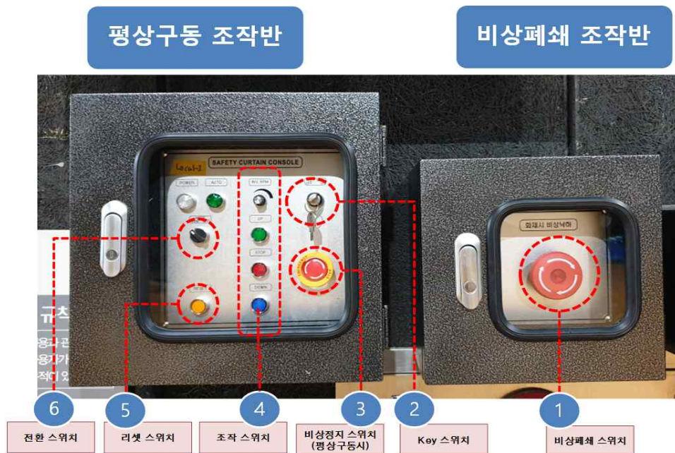
그림 4.1 구동 및 비상폐쇄 조작반 예
